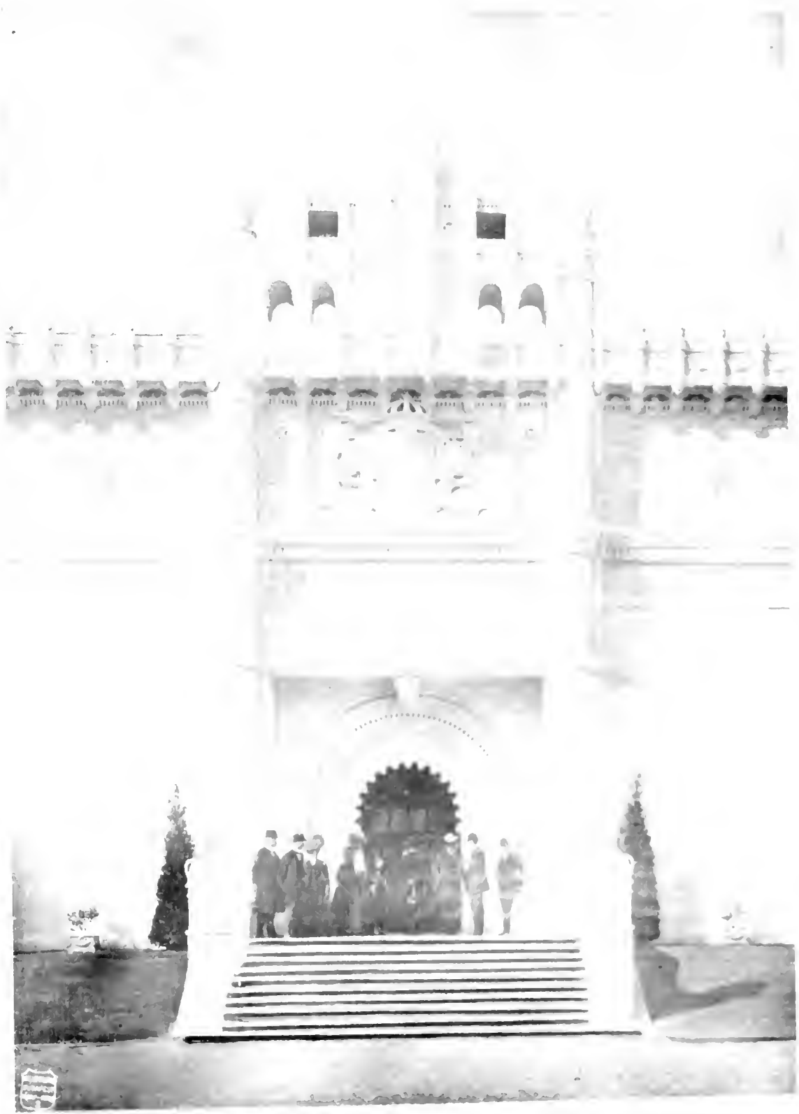
FERDINAND BOBERG. EIN TOR DES HAUPTGEBÄUDES DER STOCKHOLMER AUSSTELLUNG 1909.
